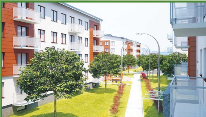
Osiedle Kalwaryjska 45 Góra Kalwaria, ul. Kalwaryjska
