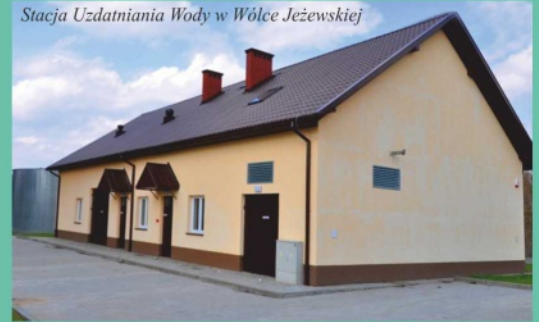
Stacja Uzdatniania Wody w Wólce Jeżewskiej
